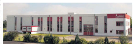
Zwei Monate wurde die Halle in Lauingen auf Vordermann gebracht und zu einem modernen Arbeitsplatz gestaltet. Fotos (2): privat
